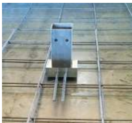
Fondo cassero Fond de coffrage
