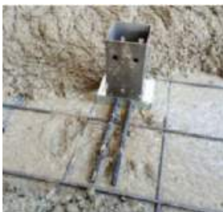
1° getto - lastra esterna 1er coulage - dalle extérieure
