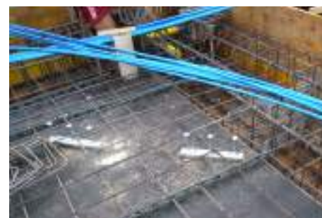
Ancoraggio pareti - Bosco verticale Milano Ancre mural - Forêt verticale de Milan, Italie
