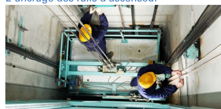
Ancoraggio delle guide per ascensori L'ancrage des rails d'ascenseur
