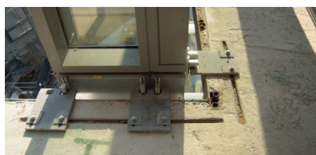
Ancoraggi delle facciate del grattacielo Diamante a Milano area Porta Nuova - Garibaldi Les ancrages des façades du gratte-ciel Diamante à Milan Porta Nuova - zone Garibaldi
