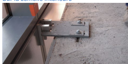
Ancoraggi delle facciate del grattacielo Diamante a Milano area Porta Nuova - Garibaldi Les ancrages des façades du gratte-ciel Diamante à Milan Porta Nuova - zone Garibaldi
