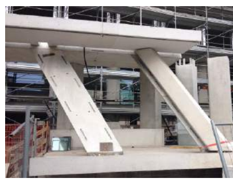
Rivestimento dei pilastri - Fond. Feltrinelli Milano Cladding of the pillars - Fondazione Feltrinelli Milano-Italy
