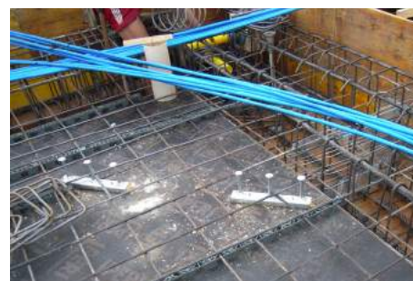
Ancoraggio pareti - Bosco verticale Milano Sideboard - Bosco verticale Milano, Italy
