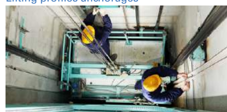
Ancoraggio delle guide per ascensori Lifting profiles anchorages
