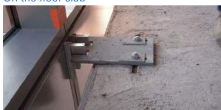
Ancoraggi delle facciate del grattacielo Diamante a Milano area Porta Nuova - Garibaldi Skyscraper Diamond facade anchorages in Milan area Porta Nuova - Garibaldi
