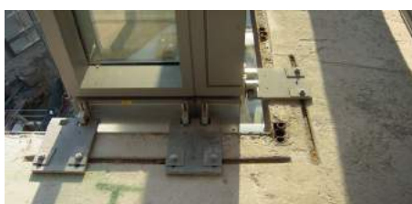
Ancoraggi delle facciate del grattacielo Diamante a Milano area Porta Nuova - Garibaldi Skyscraper Diamond facade anchorages in Milan area Porta Nuova - Garibaldi
